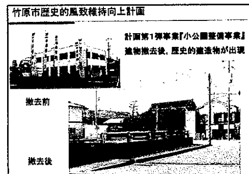
【建物撤去により歴史的建造物が出現】
