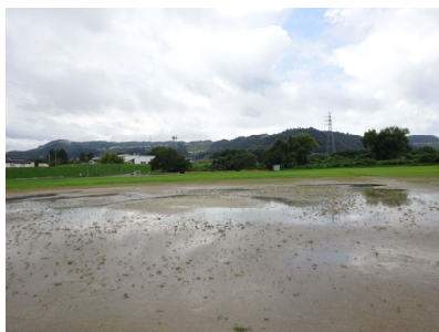
グラウンド（舗装） 不陸あり
