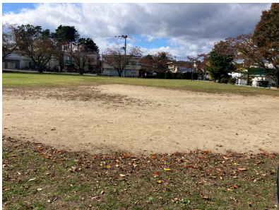
グラウンド（舗装） 不陸あり
