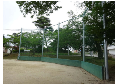
バックネット 支障なし
