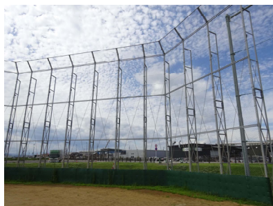
バックネット 支障なし
