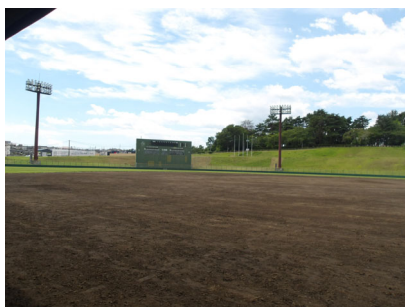
球場（舗装） クレイ舗装支障なし
