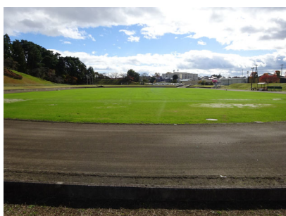
トラック（舗装） クレイ舗装支障なし
