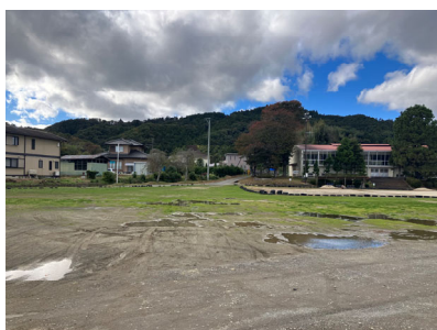
グラウンド（舗装） 不陸、水はけが悪い
