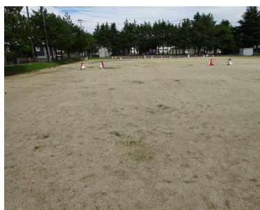
グラウンド（舗装） クレイ舗装支障なし
