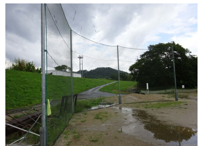
バックネット 支障なし
