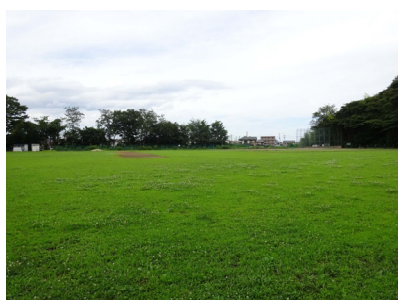
グラウンド（舗装） 草木が繁茂し、水はけが悪い
