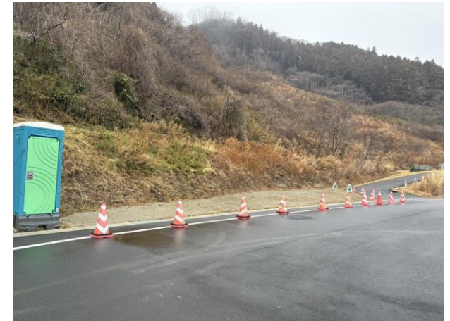
駐車場整備箇所の様子
